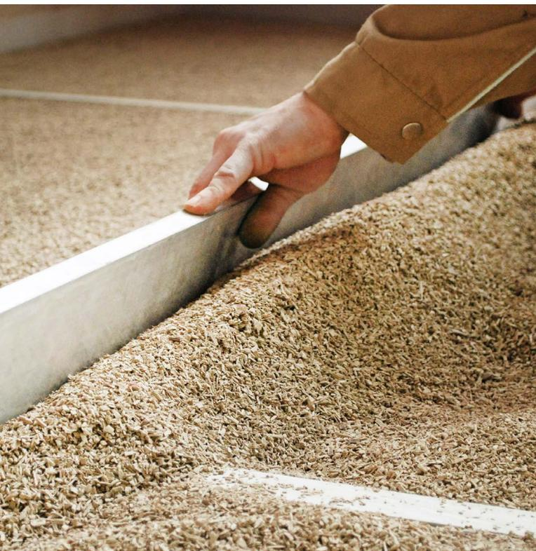
**EINBRINGEN, ABZIEHEN, FERTIG.** CW1000 wird ohne Wasser oder Bindemittel eingebracht und ist Dank der nachgewiesenen Lagestabilität sofort nach dem Abziehen begehbar.
