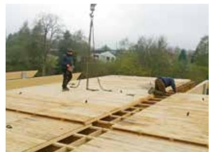
Zimmermannsmäßige Verbindung der Dachelemente über Montageöffnungen
