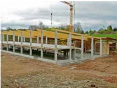
Haupttragwerk: Gabelgelagerte Brettschicht-holzträger auf Stahlbetonstützen
