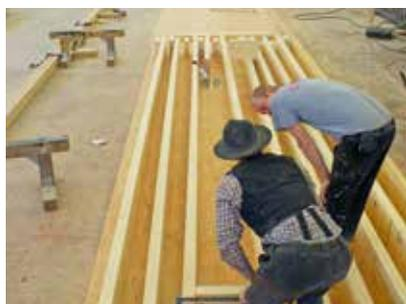
Basis der Deckenkonstruktion: STEICO LVL. In Form von Rippendecken wurden Spannweiten bis 12 m realisiert.
