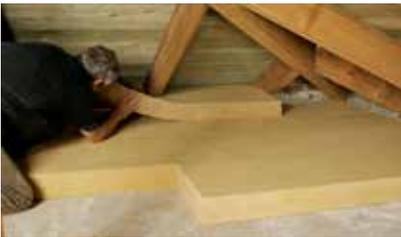
Mit den stabilen STEICO<sup>top</sup> Dämmplatten lassen sich schnell große Flächen dämmen. Der Anschluss an Details wie Fußpfetten gelingt passgenau. Da die Platten glattkantig sind, müssen bei STEICO<sup>top</sup> Randstücken keine Plattenprofile beigearbeitet werden; schwieriges Einpassen unter beengten Platzverhältnissen entfällt. Wird zweilagig gearbeitet, empfiehlt sich die Verlegung mit Fugenversatz.
